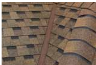
Калифорнийская ендова (один из вариантов открытого способа)
